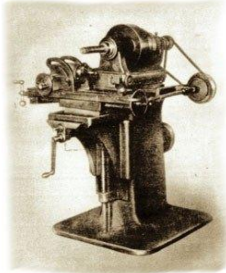
Primera fresadora universal, fabricada por Joseph R. Brown en 1862. Estaba equipada con divisor, consola con desplazamiento vertical, curso transversal y avance automático de la mesa longitudinal con la aplicación de la transmisión Cardan.
